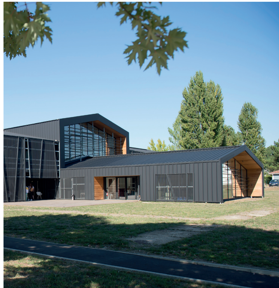
Campus Landes - Le site de Mont de Marsan (40)
